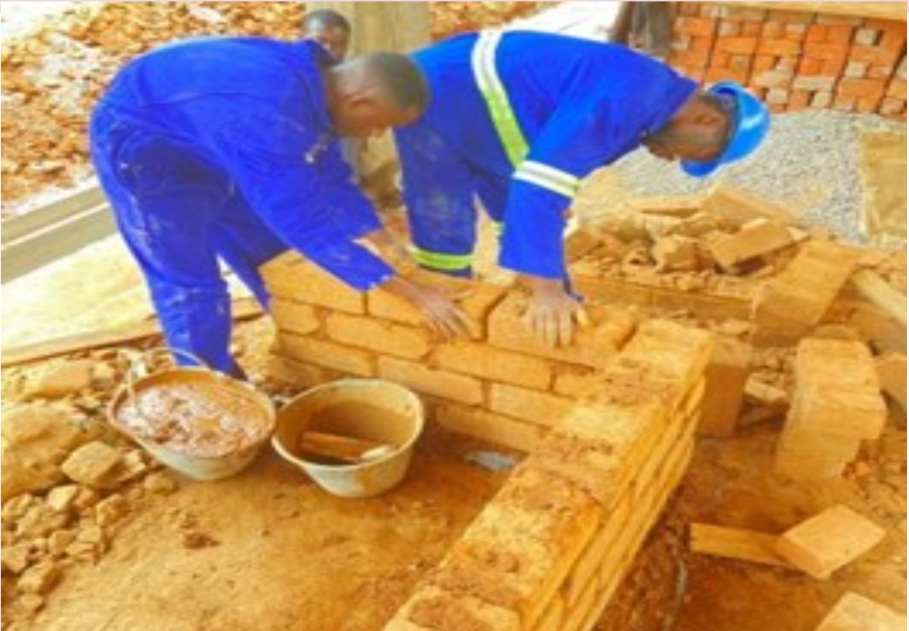
Réalisations d'un muret avec retour d'angle (maçonnerie avec mortier de terre)
