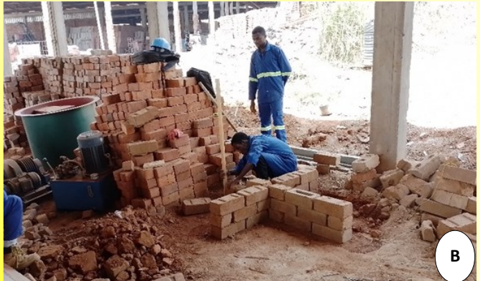
A et B: Réalisations d'un muret en maçonneries sèches (appareillage à la française)
